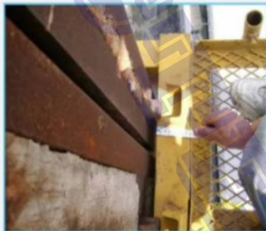
平衡重固定轴短，固定不可靠
